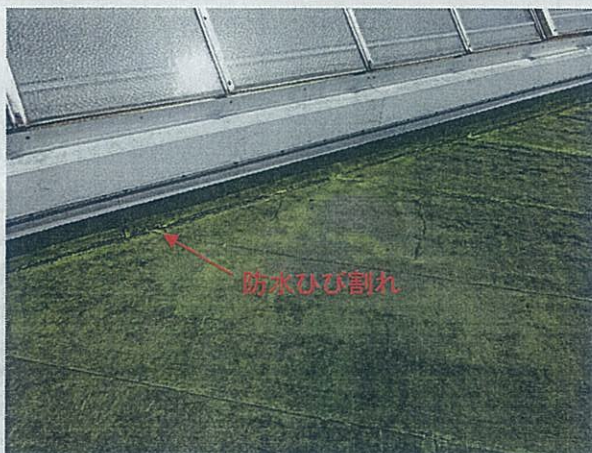
A 01 屋根 防水立上り部ひび割れ 屋上防水 -
