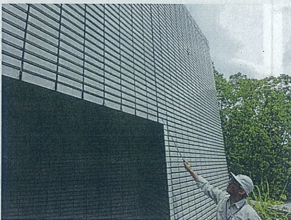
A 05 外壁 外壁仕上 全面
