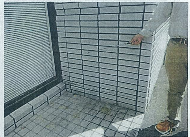
A 05 外壁 外壁仕上 全面
