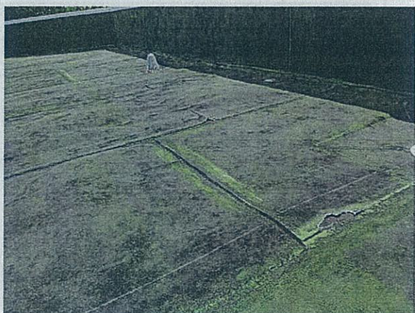
A 01 屋根 防水ジョイント部劣化状況 ジョイント部の浮き上がりがみられる 屋上防水 -
