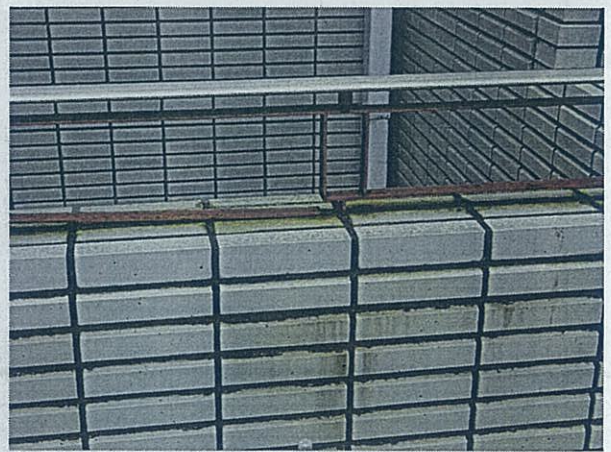
A 10 その他 手すり錆及び破損 ドライエリア手すり 1階
