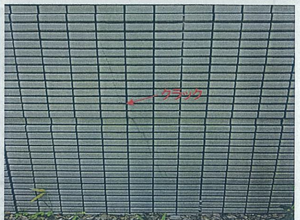
A 05 外壁 外壁仕上 全面
