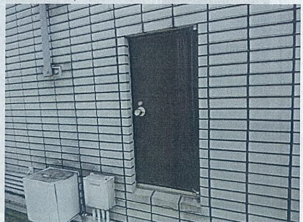
A 07 外部建具 チョーキングが見られる スチールドア PH
