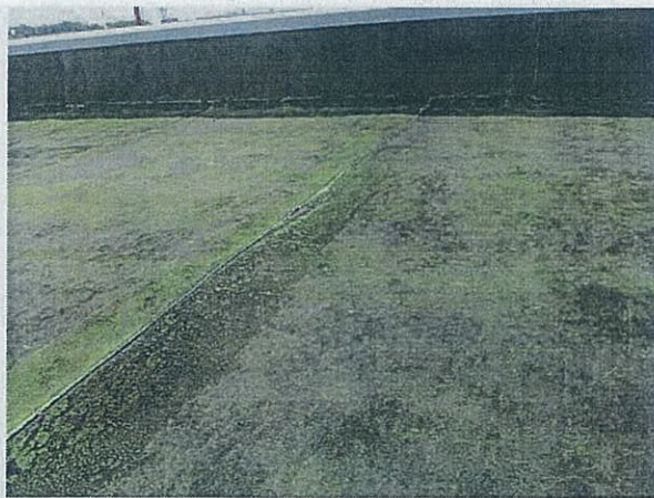
A 01 屋根 防水ジョイント部劣化状況 ジョイント部の浮き上がりがみられる 屋上防水 -
