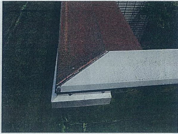
A 02 屋根 笠木ジョイント部シール劣化 口開き 屋上防水 笠木
