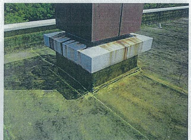
A 03 屋根 架台塗膜防水劣化 設備機器錆汁 立ち上り部アスファルト防水劣化 屋上防水 機器架台廻り
