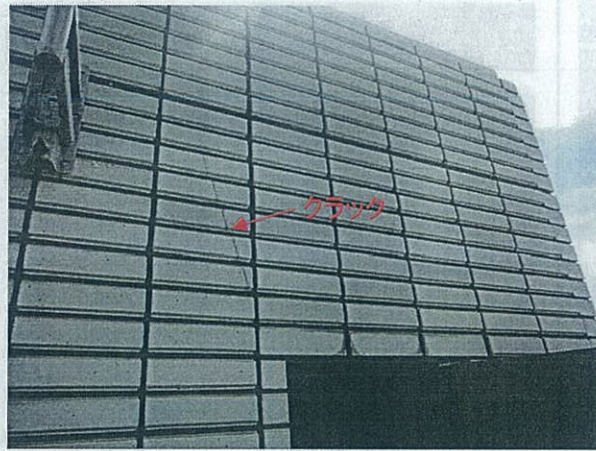
A 05 外壁 外壁仕上 全面
