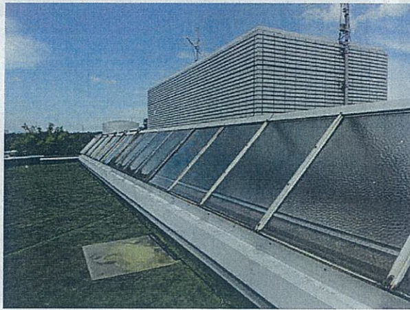
A 04 屋根 トップライト 2階屋上
