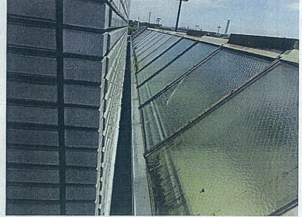
A 04 屋根 トップライト 2階屋上
