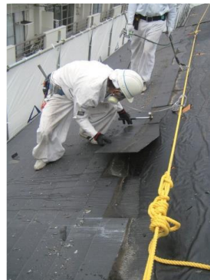
スレートの除去
