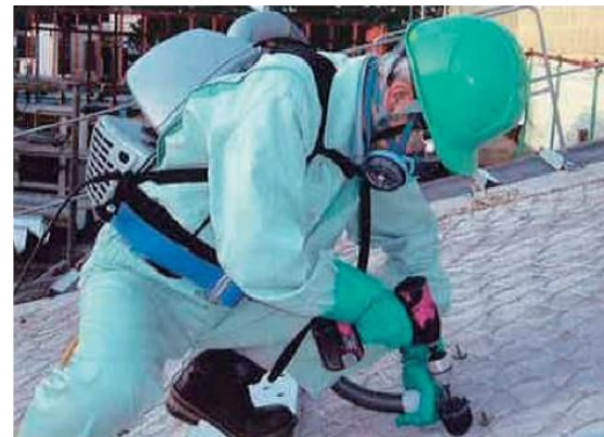
集じん回収（高性能真空掃除機）
