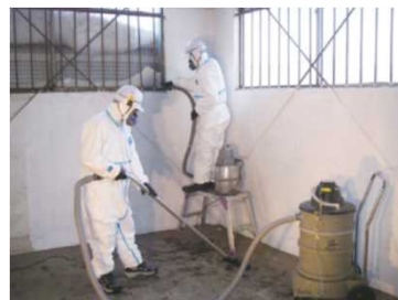
高性能真空掃除機を用いた作業場内の仕上げ清掃
