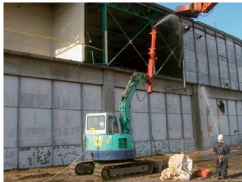
湿潤化の例(散水)
