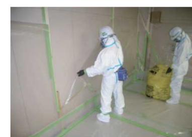
養生シートの撤去
