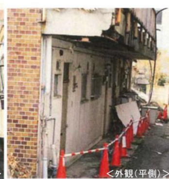
外壁、手すりが崩落した事例
