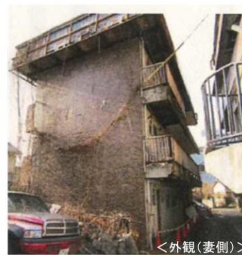
外壁、手すりが崩落した事例
