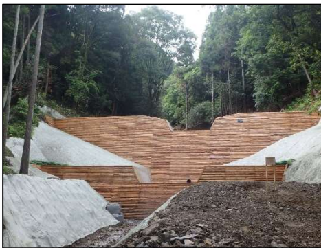
土石流発生を防止する治山ダムの整備<茨木市>
