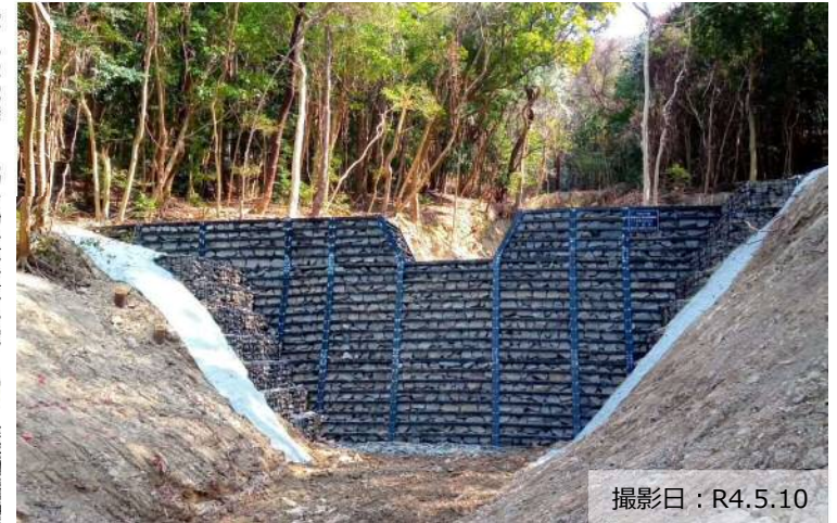
写真① 治山ダム（鋼製）の設置状況
