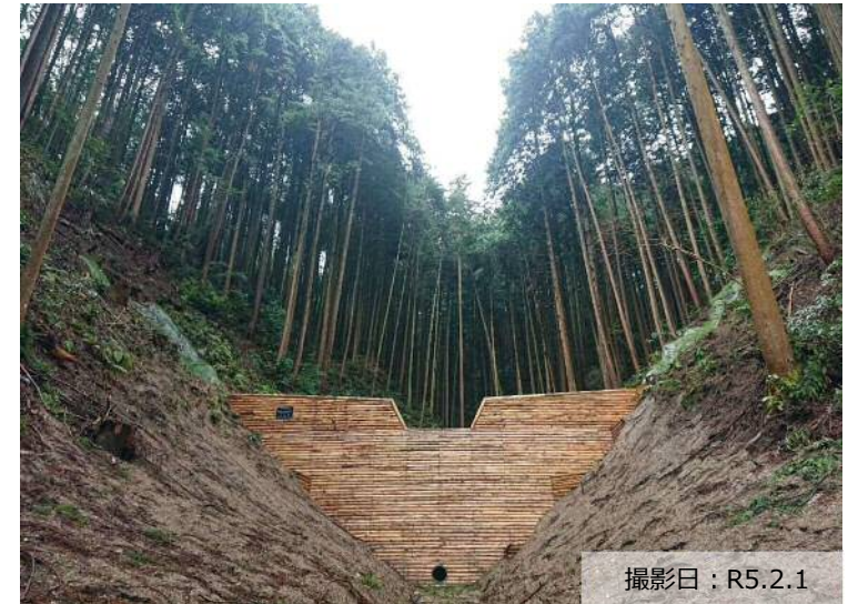
写真① 治山ダム（コンクリート）の設置状況
