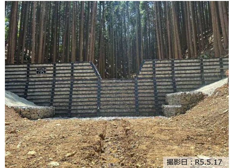
写真① 治山ダム（鋼製）の設置状況
