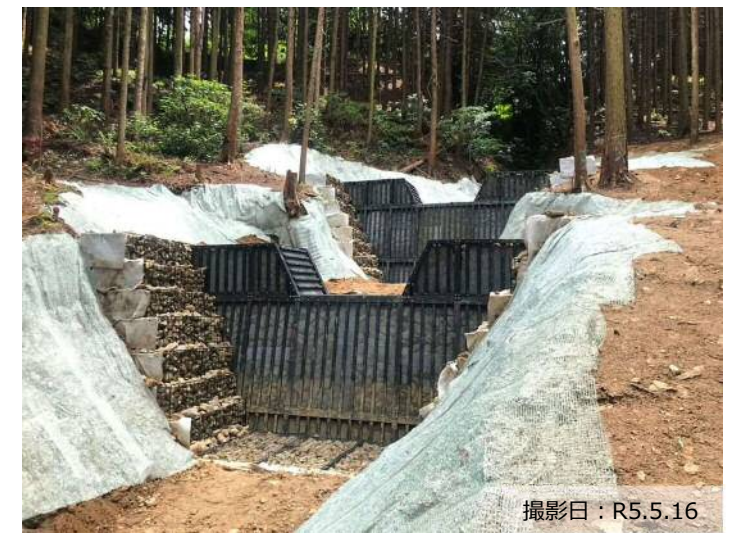
写真① 治山ダム（鋼製）の設置状況
