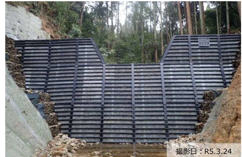
写真① 治山ダム（鋼製）の設置状況
