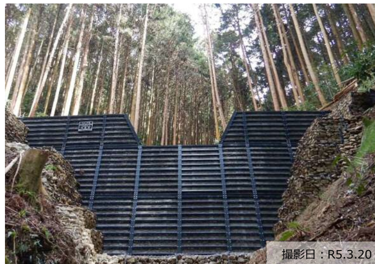
写真① 治山ダム（鋼製）の設置状況
