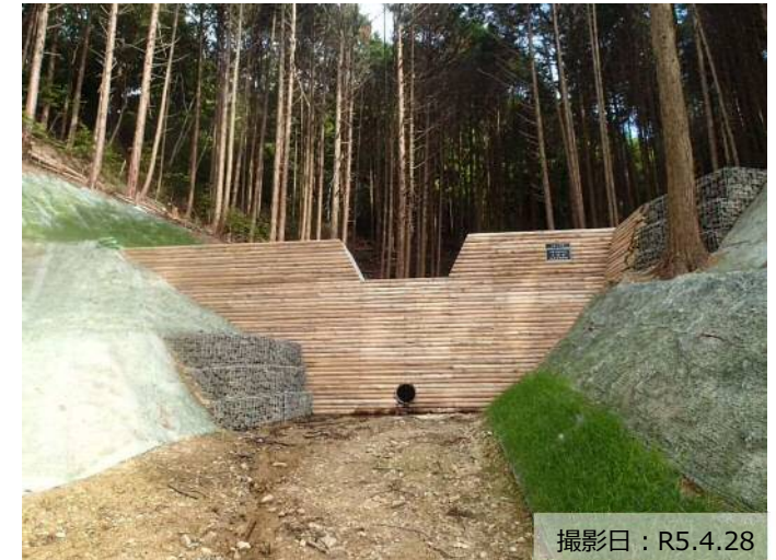
写真② 治山ダム（コンクリート）の設置状況
