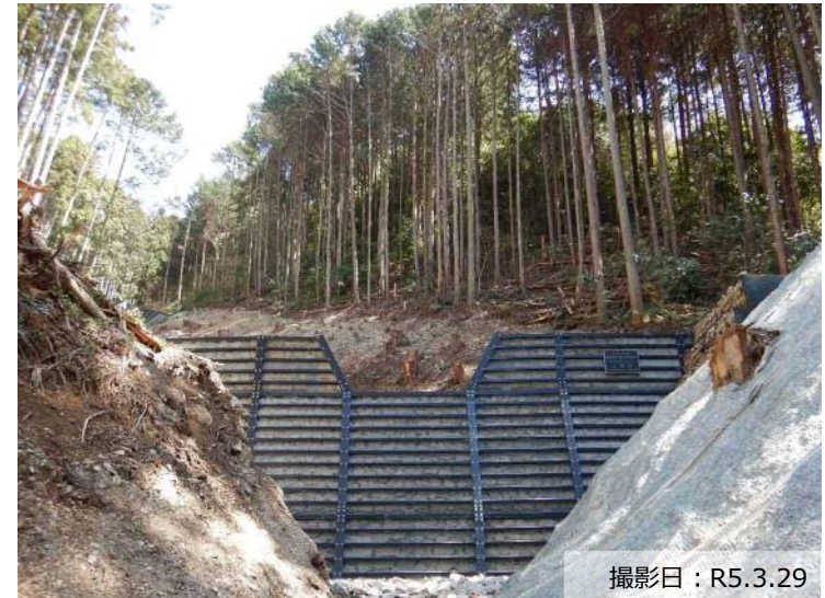
写真① 治山ダム（鋼製）の設置状況
