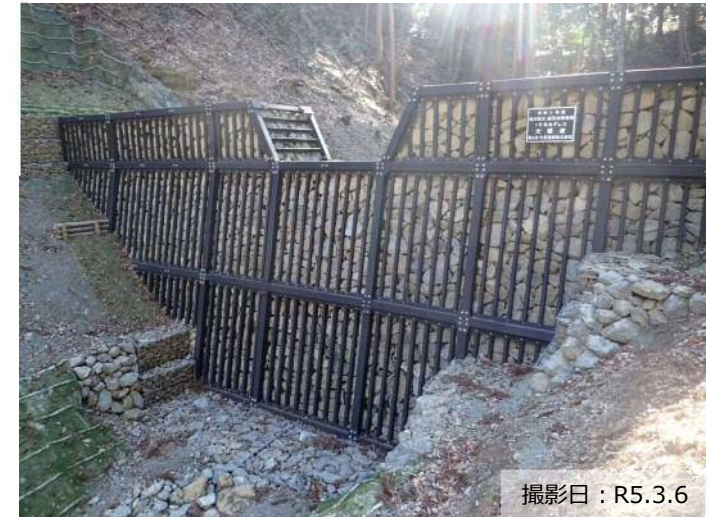
写真① 治山ダム（鋼製）の設置状況
