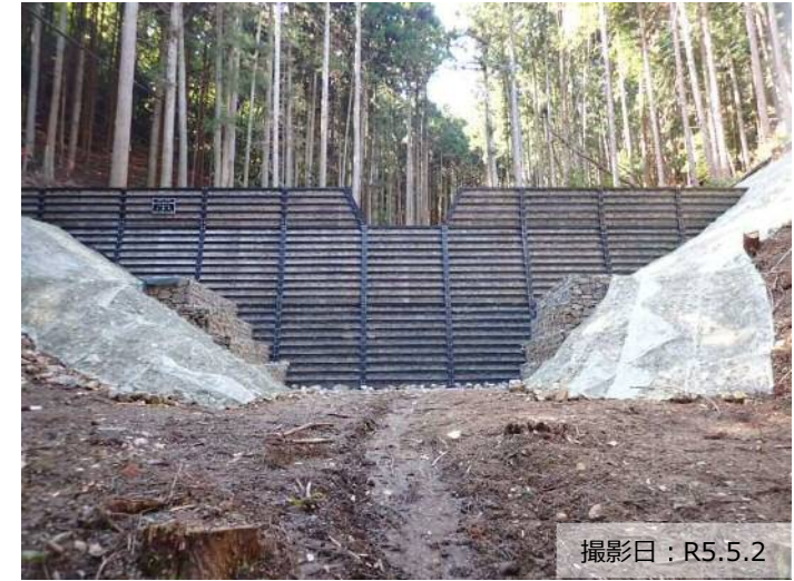
写真① 治山ダム（鋼製）の設置状況
