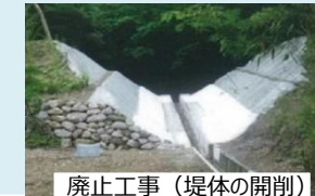
廃止工事（堤体の開削）
