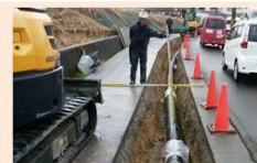
パイプライン布設
