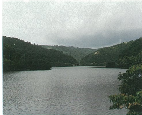
94 堀河ダム 泉南市 春の桜のシーズンには、水を満々と湛えたダムと杉、ヒノキの緑、桜の花が調和し、すばらしい景観を作り出している。
