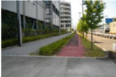
⑨ 仮設ガードレール
