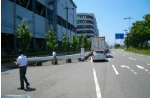
⑨ 仮設ガードレール
