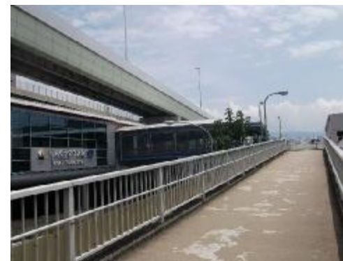
③ デッキ通路
