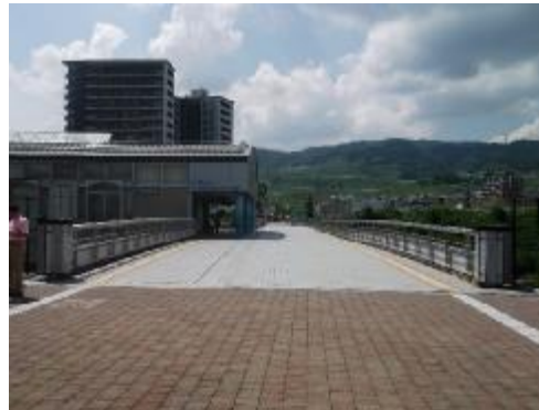
② 改札口から駅広へのデッキ
