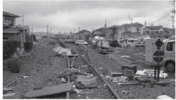
被災地はこんなところ (東日本大震災の石巻市)
