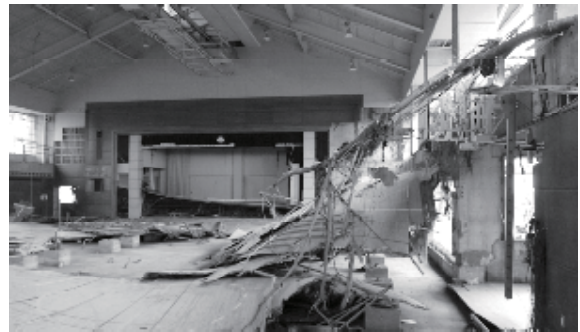
被災地はこんなところ 津波被害の体育館 床も壁も剥がれる
