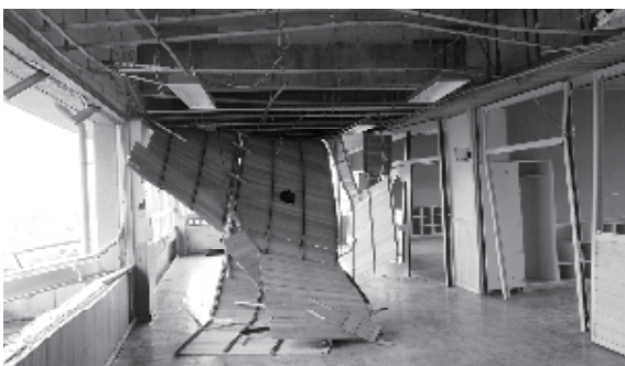
被災地はこんなところ (津波被害の学校 天井が落ちている)
