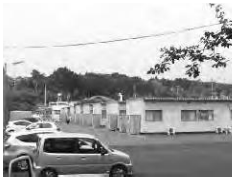
写真8：活動した仮設住宅
