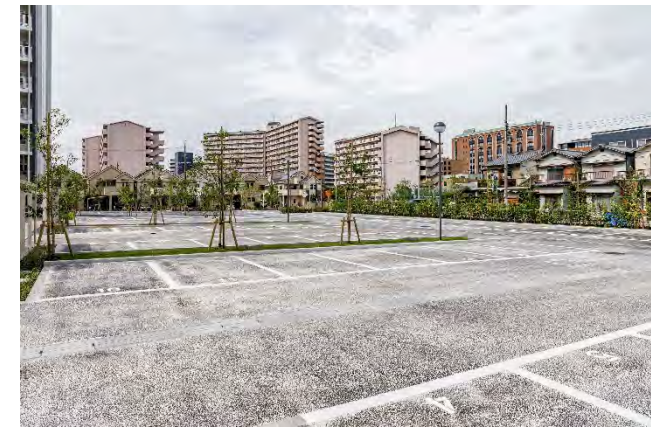
保水性舗装の駐車場
