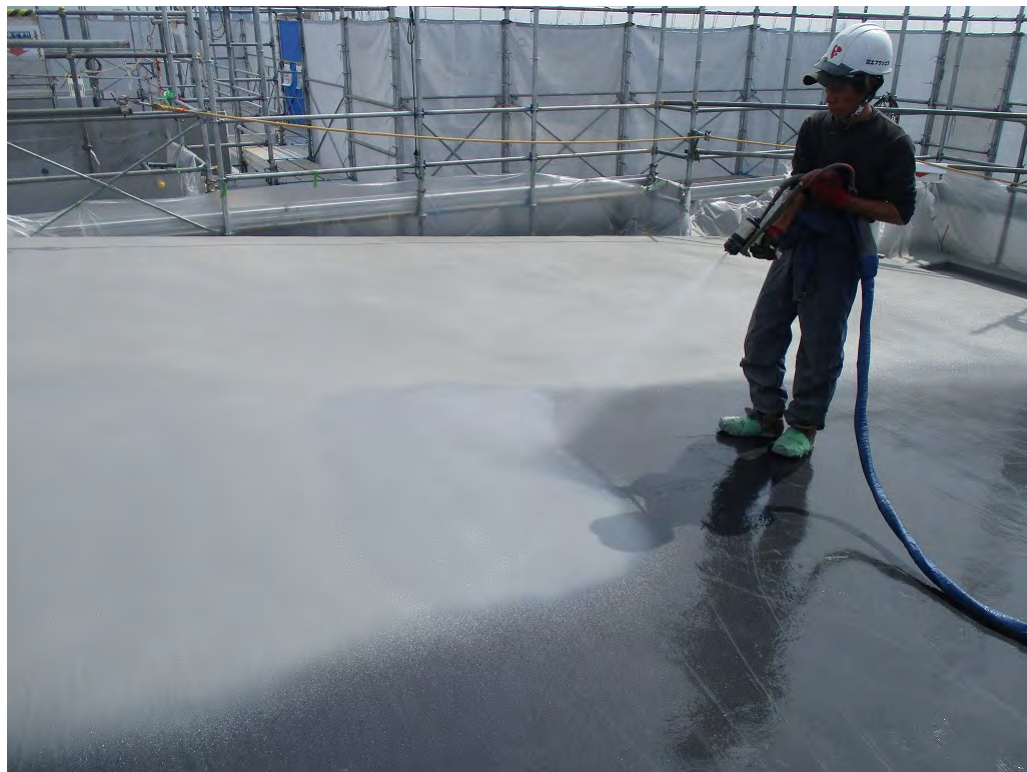
屋根：高強度ゴムアス複合塗膜防水 防水保証20年(期待耐用年数35年)
