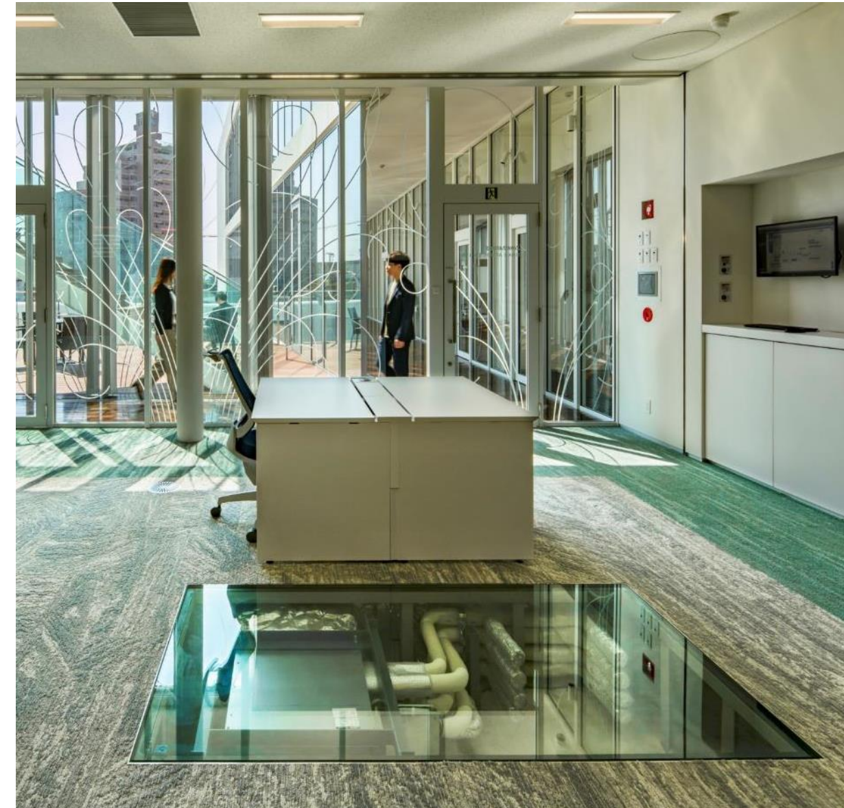
床隠蔽室内ユニットの見える化
