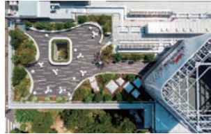
雨水を緑化散水に利用
