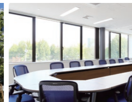
スタッフエリアの自然換気窓
