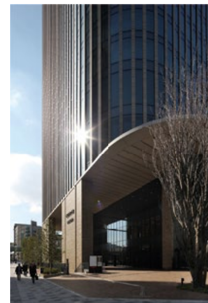
中之島フェスティバルタワー・ウエストを淀屋橋より望む（大阪の新たなランドマーク）
