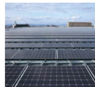
太陽光パネルの設置
