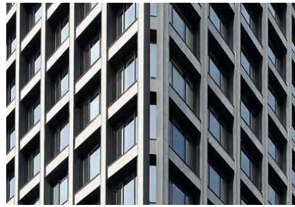
【1】鉄骨アウトフレームによる深い外壁開口部
