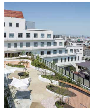
患者のリハビリ空間にも活用可能な憩いの屋上庭園
