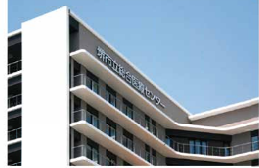
室外機の目隠しの白い妻壁と彫の深いバルコニー
