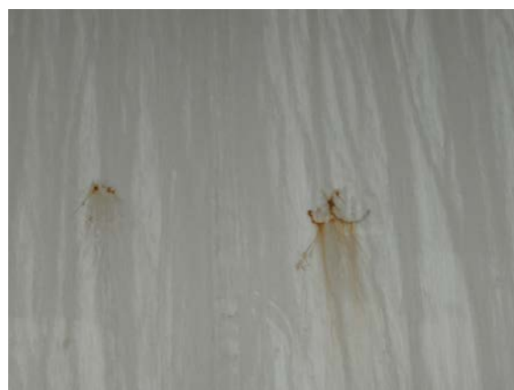
(b) 鋼板補強部
