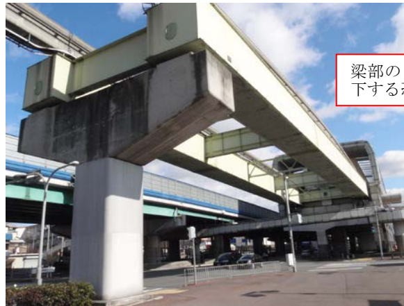
図 4.4 第三者被害が懸念される RC 橋脚の例
