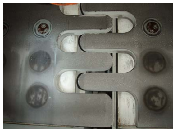
(d) 支承部(特に異常なし)
