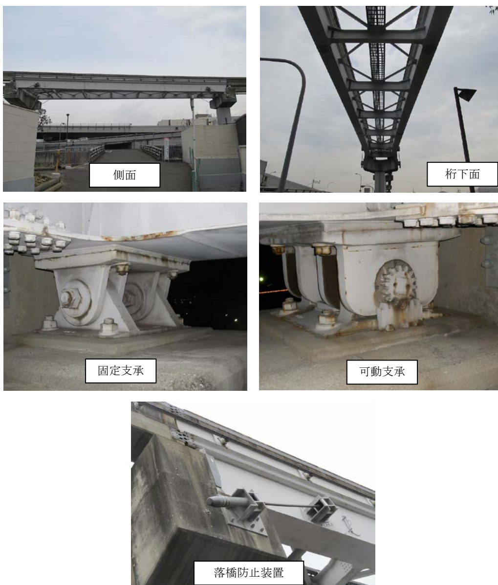
図 1.1 茨木東橋状況写真
