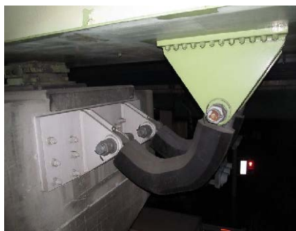
図 3.4 落橋防止装置の主な損傷状況（損傷なし）
