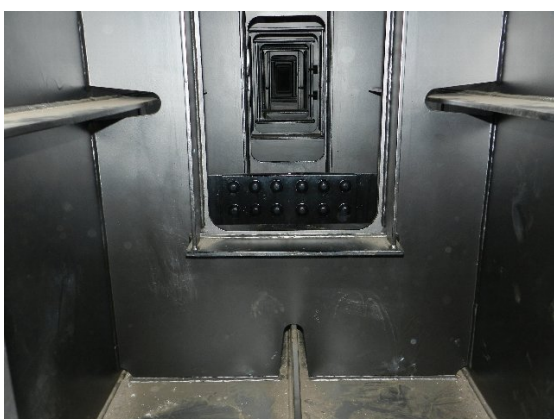
補剛桁(内面)状況
