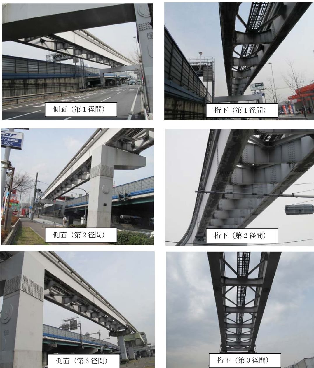
図 2.1(1) 下穂積橋状況写真
