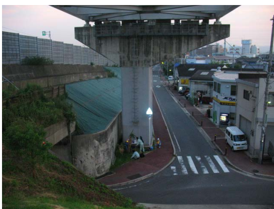
図 5.12(c) P805 周辺測定器設置状況
