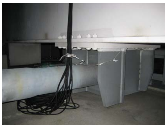
図 5.12(a) ケーブル延長状況 (P805)
