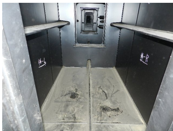
補剛桁(内面)状況
