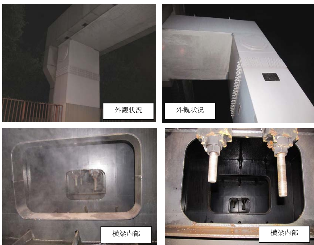
図 4.1 P433 橋脚状況写真
