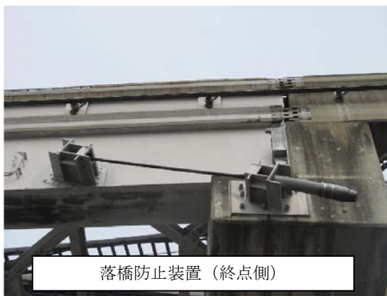
図 2.1(2) 下穂積橋状況写真
