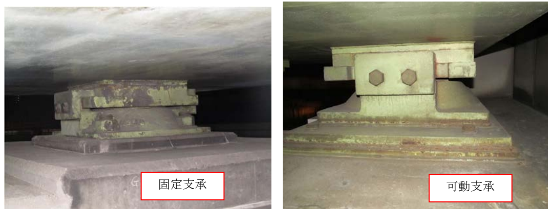
図 6.3.1 モノレール橋の支承状況（支承板支承）
