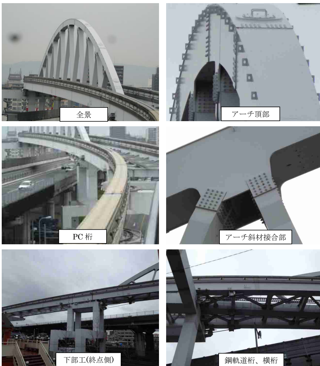
図 6.1 単弦トラスアーチ橋状況写真
