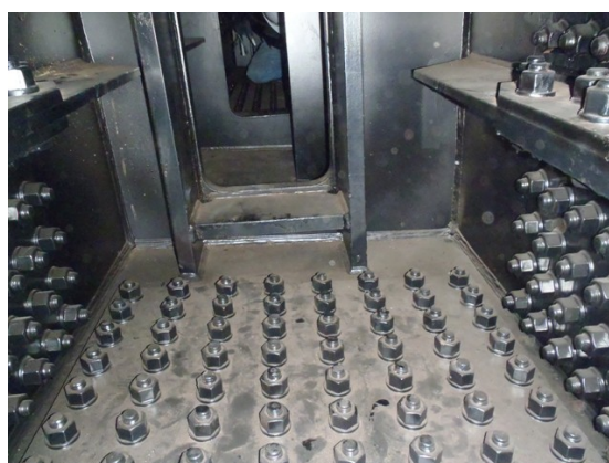
端部横桁(内面)状況
