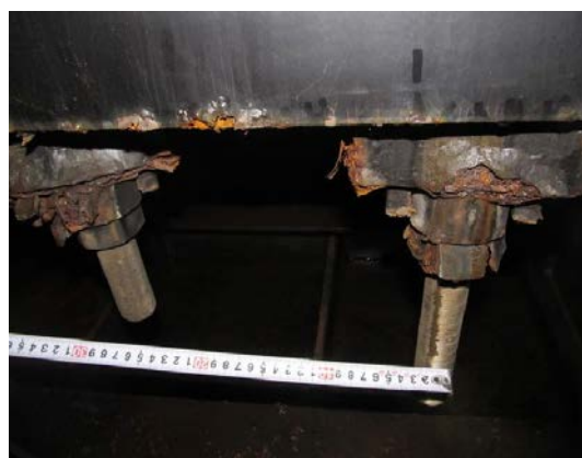
アンカーボルトの腐食
