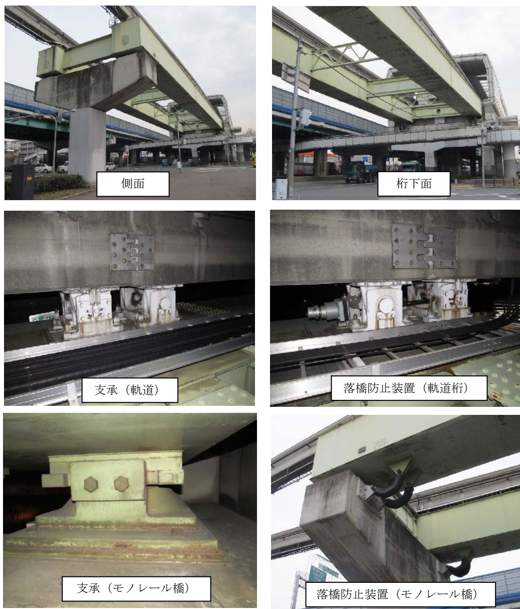
図 3.1 茨木西橋状況写真
