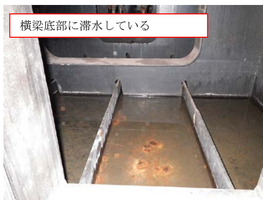
図 3.2 横梁内部の滞水状況
