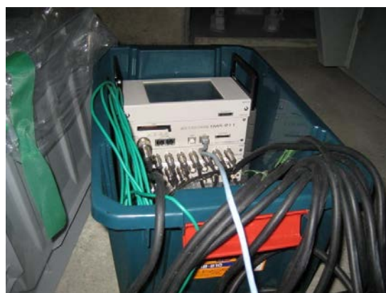
図 5.12(b) 測定器設置状況 (P805)
