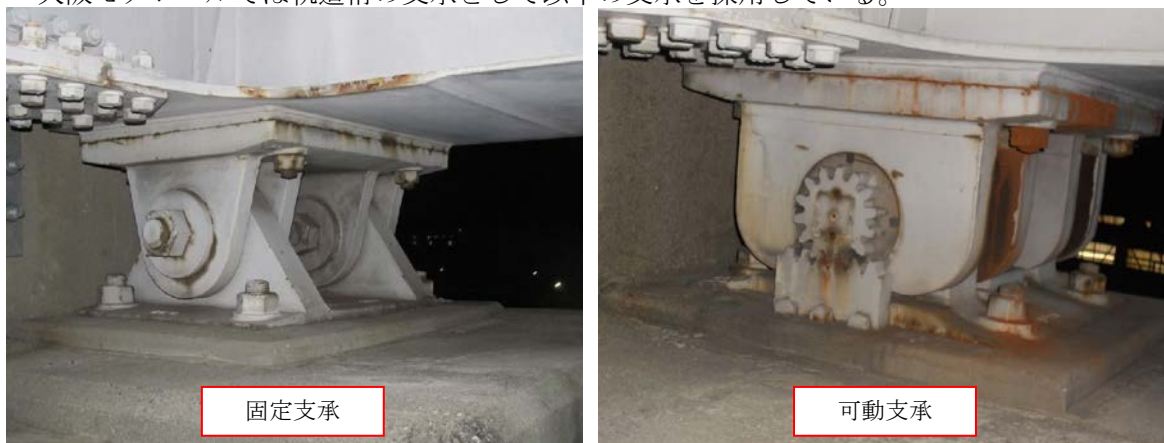
図 5.1 鋼軌道桁の支承形式
