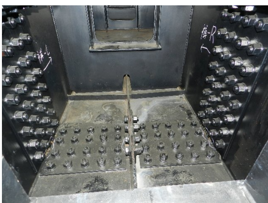
補剛桁添接部(内面)状況
