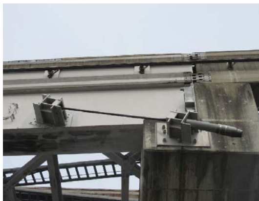
落橋防止装置 損傷なし
