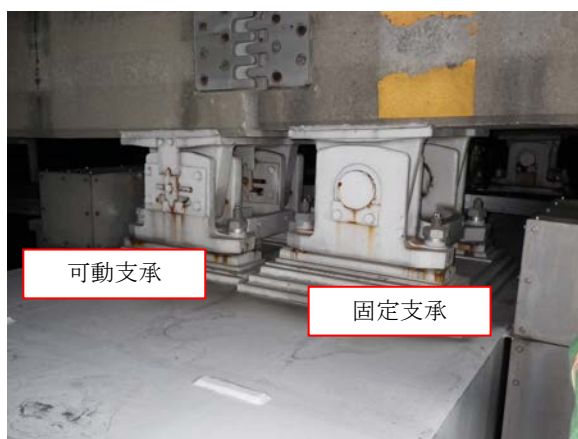
図 5.2 PC 軌道桁の支承形式
