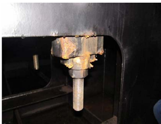
アンカーボルトの腐食
