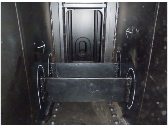
落橋防止部材
