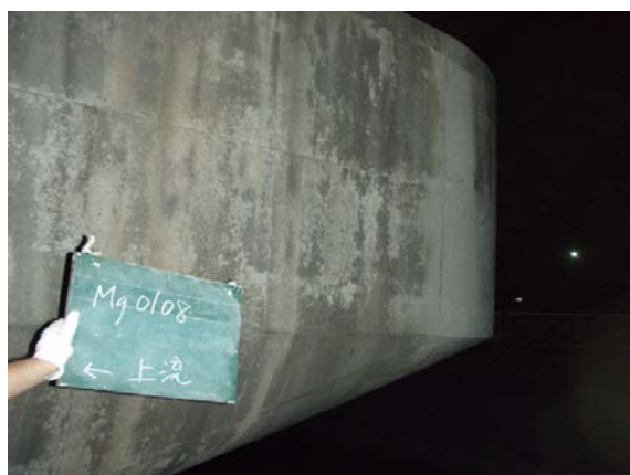
(a) コンクリート張出し部
