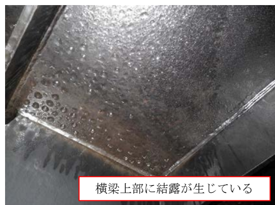
図 3.2 横梁内部の滞水状況
