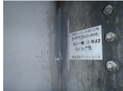
⑤防錆処理等の後処理実施後
