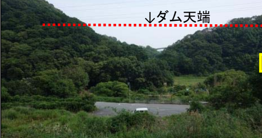
⑦ダム上流から下流を望む
