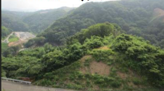
③ダム右岸から左岸を望む (西から東)
