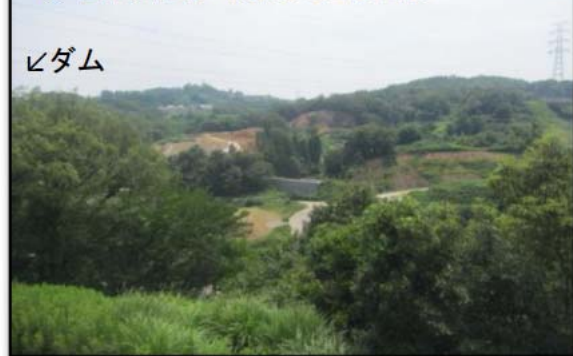
④左岸道路よりあさご谷を望む
