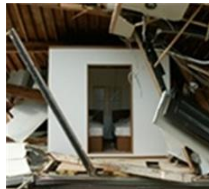
(耐震シェルターの例)
