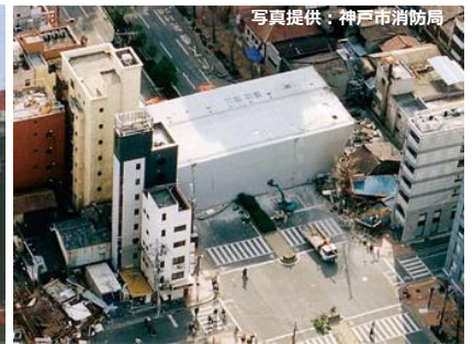
阪神・淡路大震災で倒壊し道路を閉塞したビル
