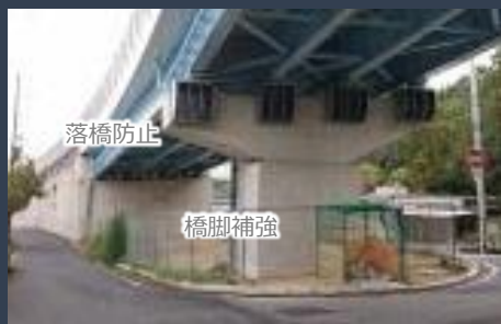
橋梁の耐震補強の様子
