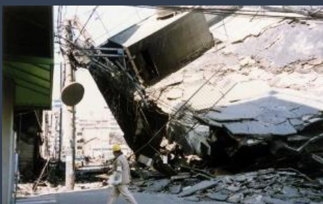
倒壊し道路を塞ぐ建築物
