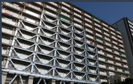
建物の耐震改修の様子
