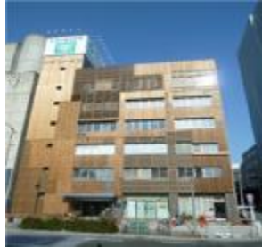
オフィスビルでの木製外壁
