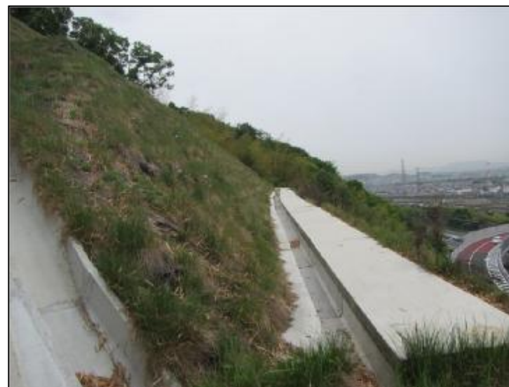
排水施設の設置状況
