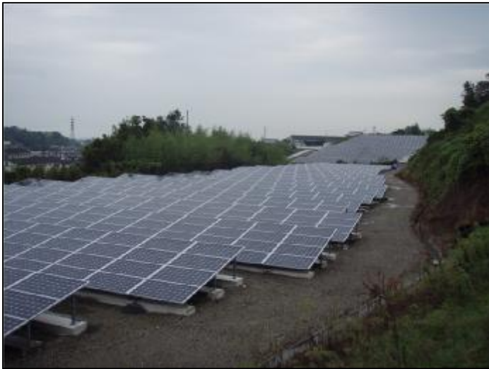
パネル設置状況
