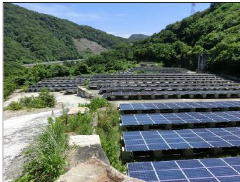
パネルの設置状況
