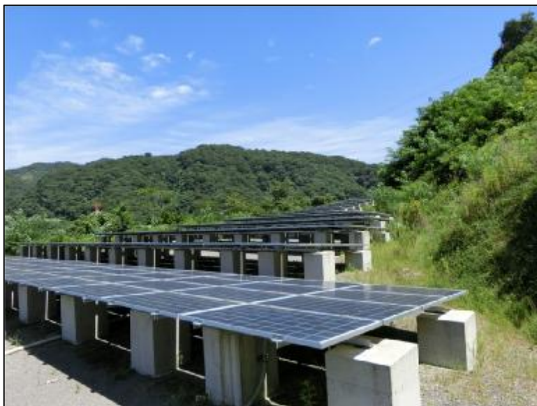
パネルの設置状況
