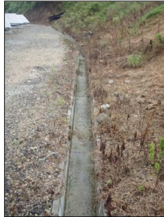
排水施設の設置状況
