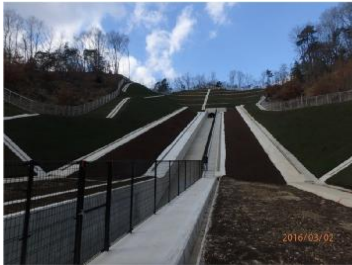
水路と切土法面緑化
