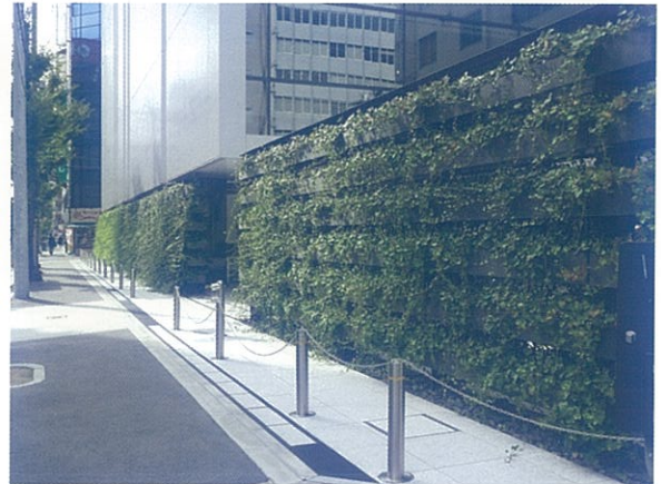
外周部の壁面緑化
