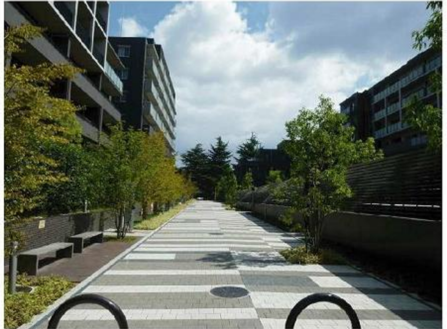
敷地内の市道を再生し緑化
