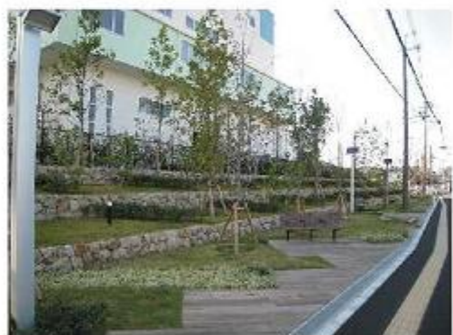
八尾市立 リサイクルセンター 所在地：八尾市曙町 主用途：公共施設 建築主：八尾市
