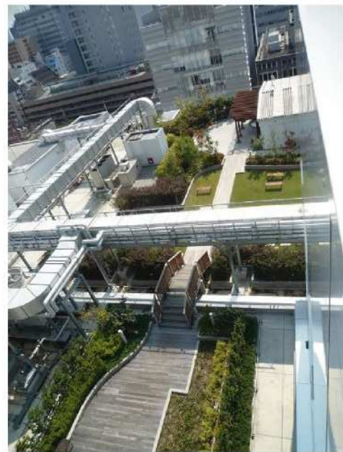
屋上緑化全景 奥が旧館・手前が新館部分
