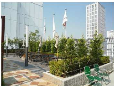
(上) 配管をカモフラージュする木製階段
