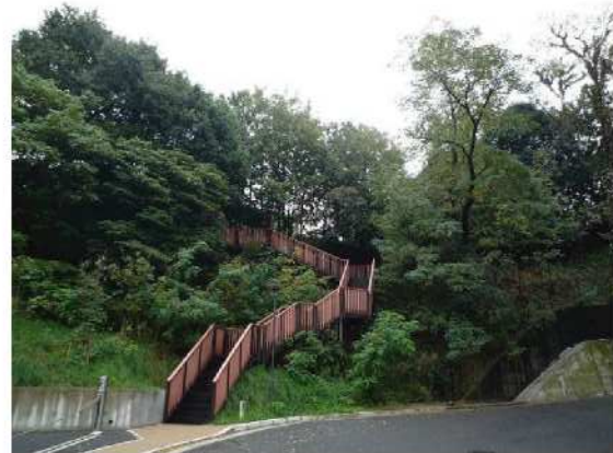
既存樹林帯に設けられた木製階段
