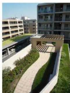
(右) 住棟間の連絡通路
