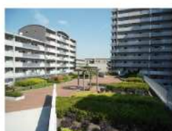
(中) 駐車場上部の緑化
