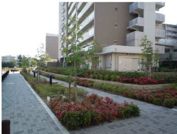
大幅なセットバックを行った接道部緑化
