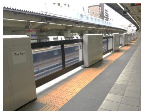
可動式ホーム柵の設置
