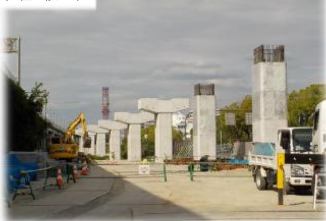
支柱建設工事
