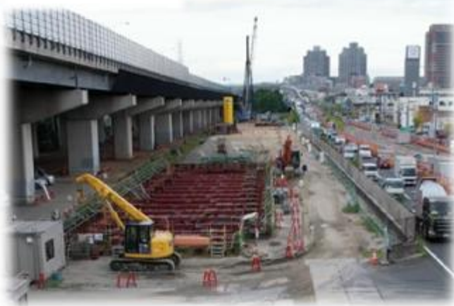
車両基地建設工事
