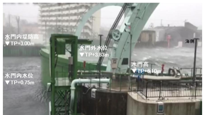
平成 30 年台風第 21 号来襲時の木津川水門
