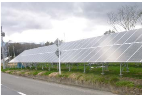
(柵塀未設置の事例)
