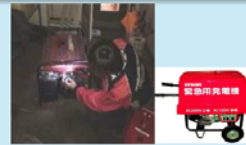
・自家発電機の導入
