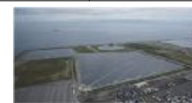
泉大津大規模太陽光発電施設
