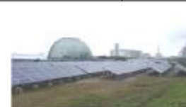
咲洲メガソーラー (大阪ひかりの泉プロジェクト)
