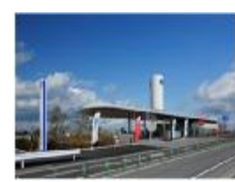
水素ステーション
