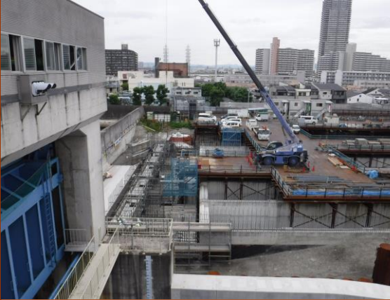
写真③—放流渠躯体工（現況）
