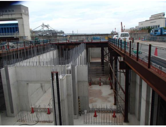
写真④—沈砂池棟（B1F）
