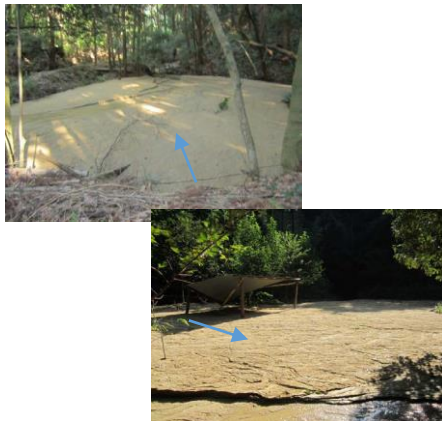
満砂となった流域内のため池
