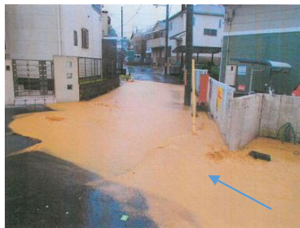
住宅地への土砂流出状況
