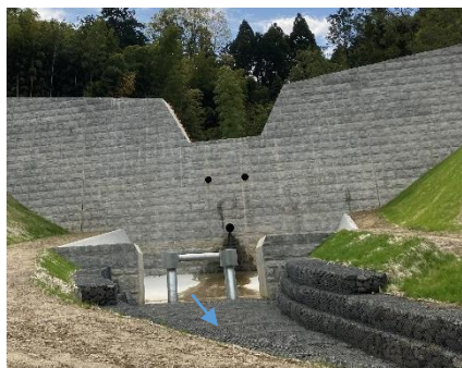
不透過型堰堤 + 流木捕捉工 天野川支川第四支溪（交野市）
