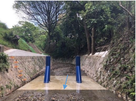
流木捕捉工の増設 オケ原川（箕面市）
