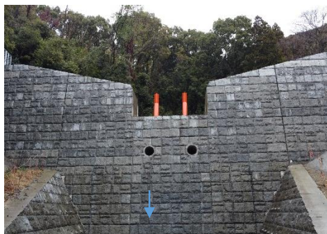
部分透過型堰堤 鬼虎川（東大阪市）
