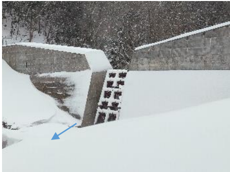
透過型堰堤 北川（能勢町）
