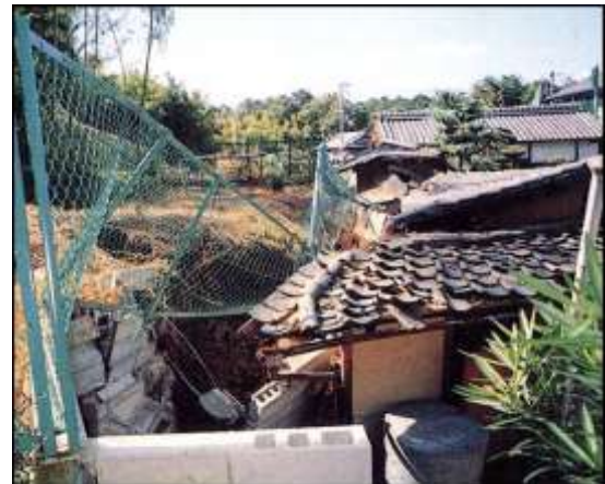
写真参 1-2 地すべり災害 (H8・杉地区)
