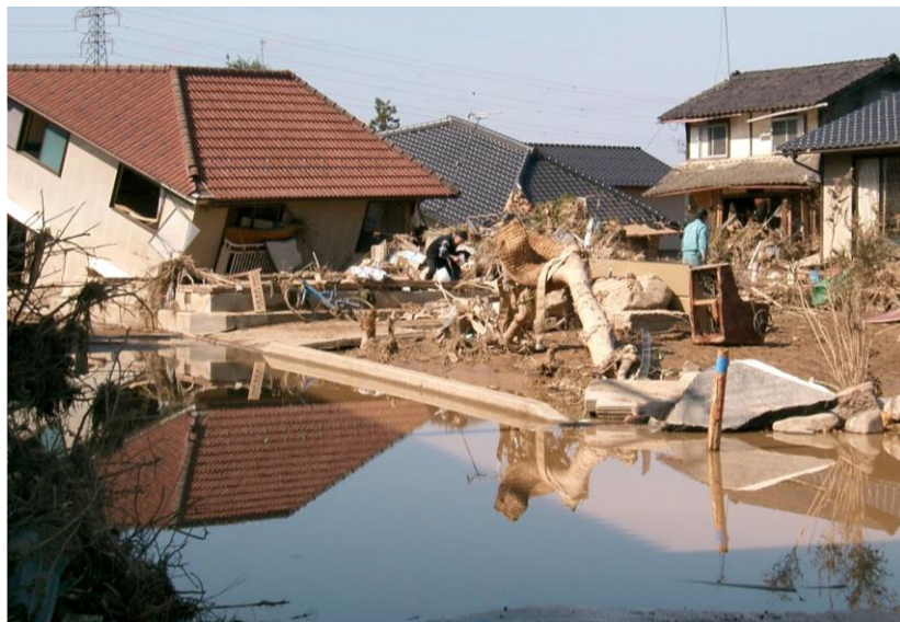
平成16年台風23号の被災状況（円山川水系出石川）
