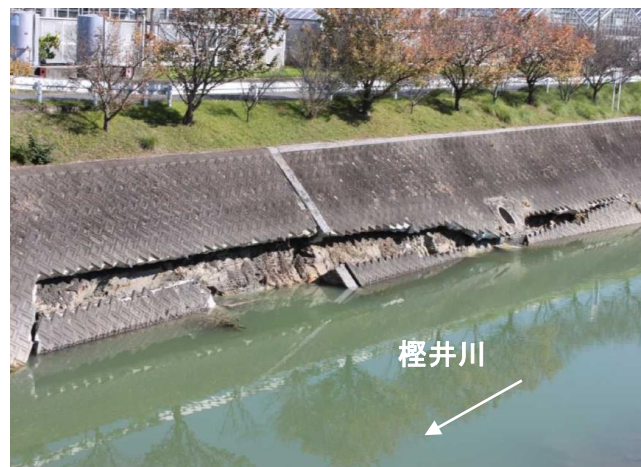
平成29年10月27日 樫井川 川原出橋上流右岸
