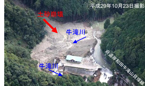
【大阪府】平成29年10月台風21号による被災牛滝川被災状況
