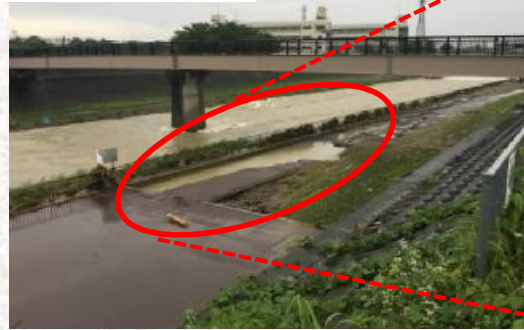
【安威川】太田橋下流左岸 護岸崩壊L=15m
