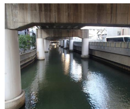
図-1.19 上大和橋下流
