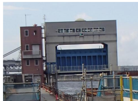
図-1.23 正蓮寺川水門
