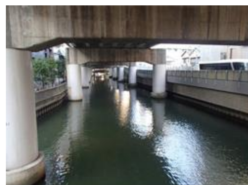
図-1.20 上大和橋下流
