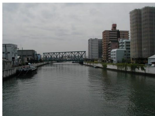
図-1.12 木津川 (尻無川分派点上流)
