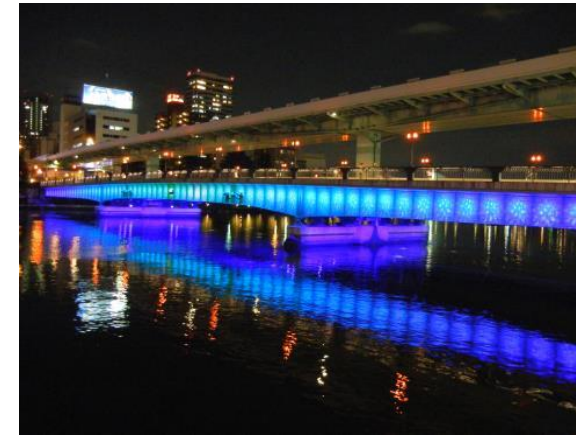
図-1.30 天満橋 (橋梁のライトアップ)
