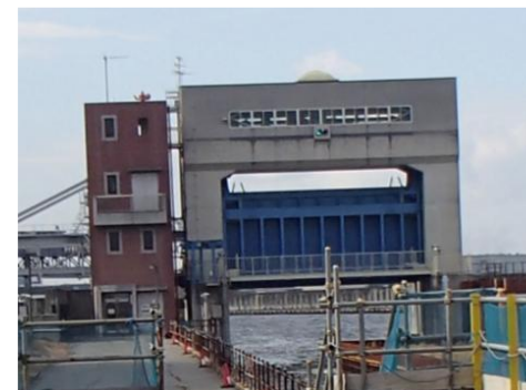
図-1.23 正蓮寺川水門
