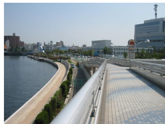
図-1.13 木津川・尻無川スーパー堤防区間 (木津川右岸)
