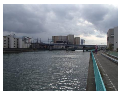
図-1.26 北港通下流
