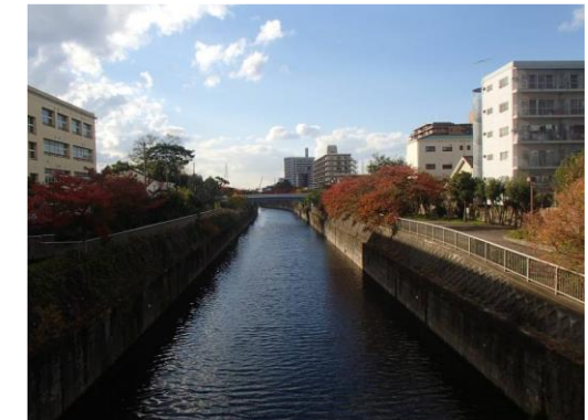
図-1.18 住吉川水門上流側
