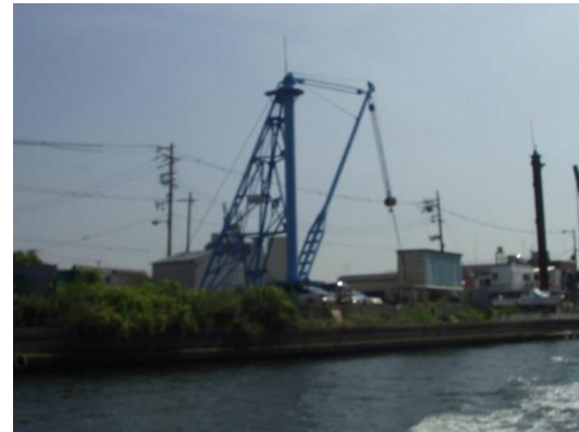
図-1.16 尻無川水門上流 (左岸)
