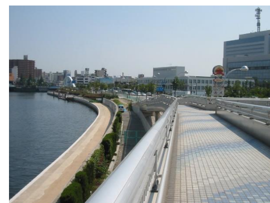
図-1.12 木津川・尻無川スーパー堤防区間 (木津川右岸)
