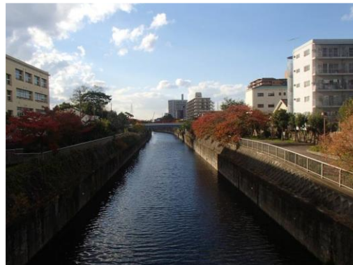
図-1.17 住吉川水門上流側
