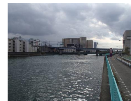
図-1.26 北港通下流
