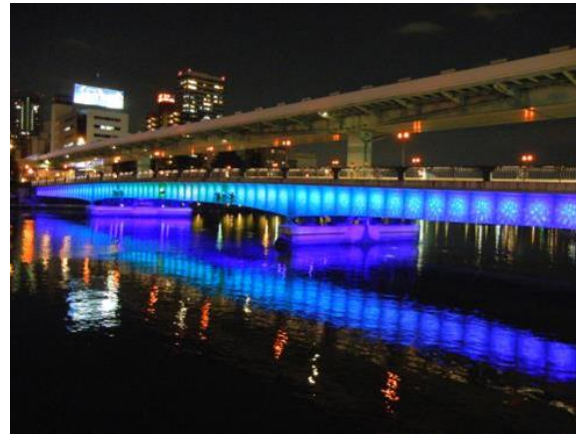
図-1.30 天満橋 (橋梁のライトアップ)
