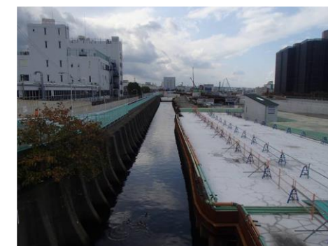
図-1.24 北港新橋下流
