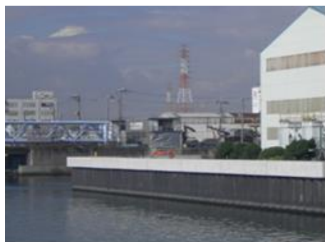
図-1.17 すみよしがわ 住吉川水門下流側
