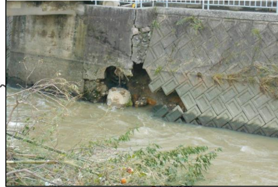
②西除川栄橋下流左岸
