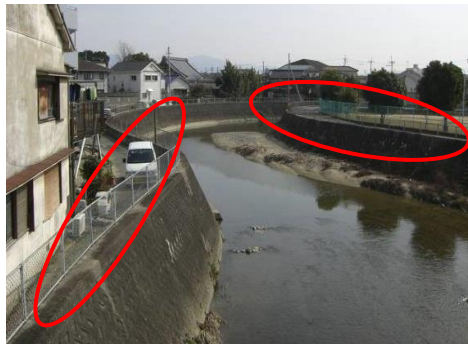
東除川改修前
