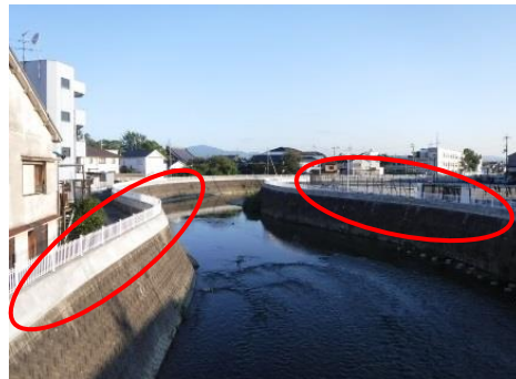
東除川改修後
