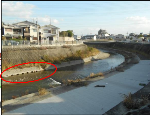
①西除川新布忍橋上流 魚巢ブロック ②西除川新西除橋上流 護床工（木工沈床）
