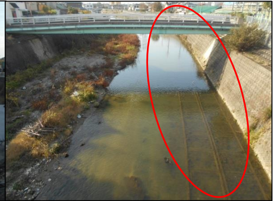
①西除川新布忍橋上流 魚巢ブロック ②西除川新西除橋上流 護床工（木工沈床）
