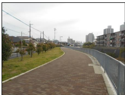
西除川光風橋上流 遊歩道整備
