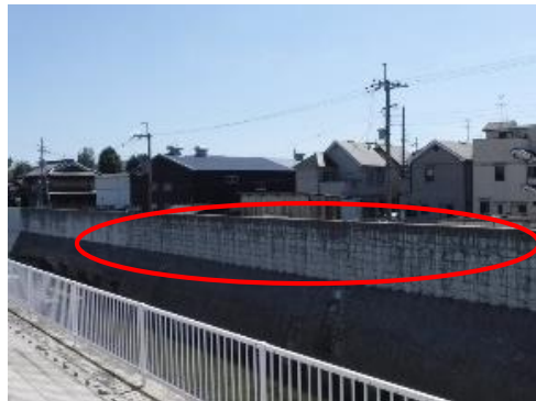
落堀川改修後
