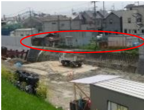
落堀川改修前
