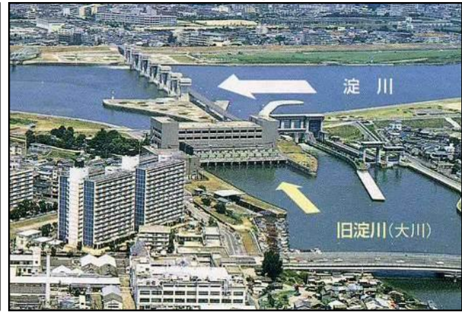
毛馬排水機場
