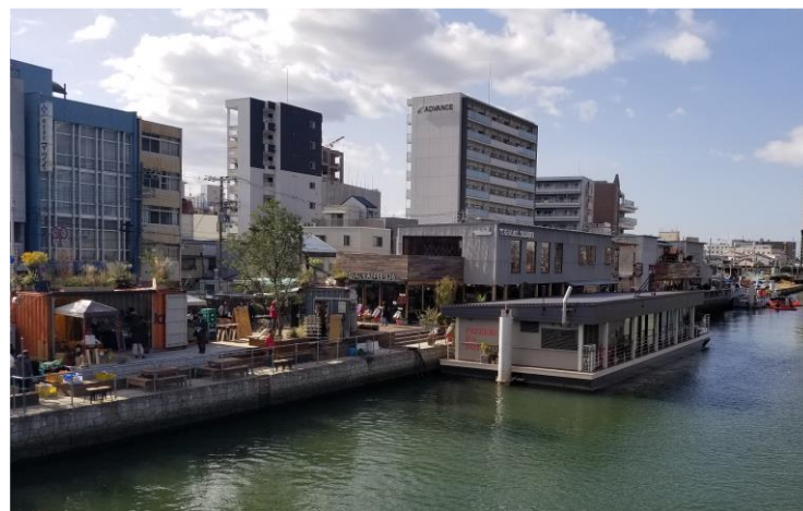
賑わい空間整備箇所(尻無川)
