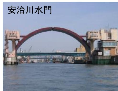
三大水門により締切、毛馬排水機場(吐出量 $330\text{m}^3/\text{s}$ )と河道内1mの貯留により、ジェーン台風時の降雨(最大時間降雨19mm)に対応する。
