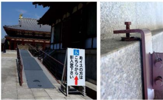
図2 基壇への仮設スロープの設置
