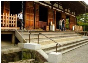
図3 仮設の手すり
