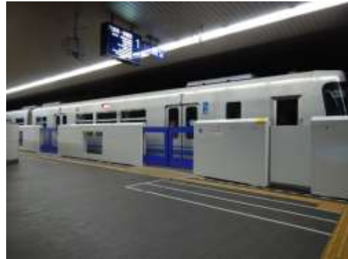
大阪高速鉄道(株) 千里中央駅
