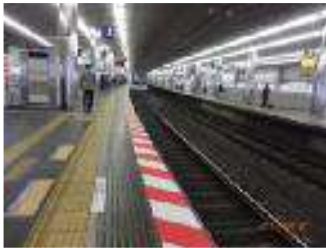
ホーム端の注意喚起シート
